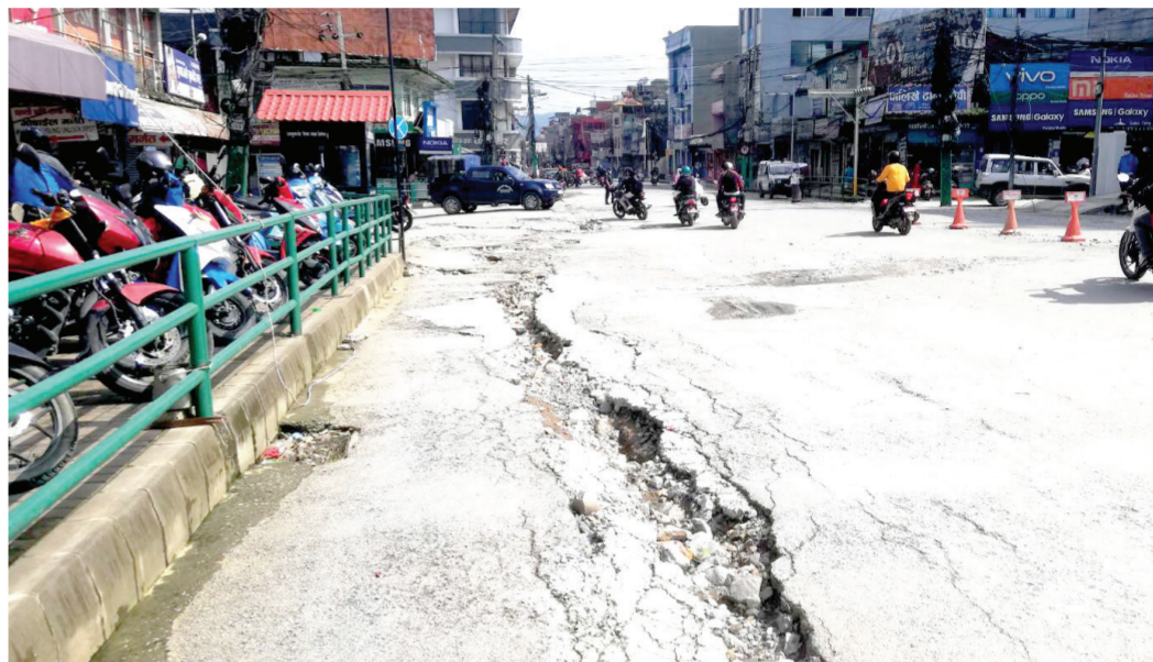
महेन्द्रपुलमा खानेपानीको पाइप बिच्छ्याएर पिच हुन बाँकी सडक। तस्बिर : सञ्जय/समाधान
